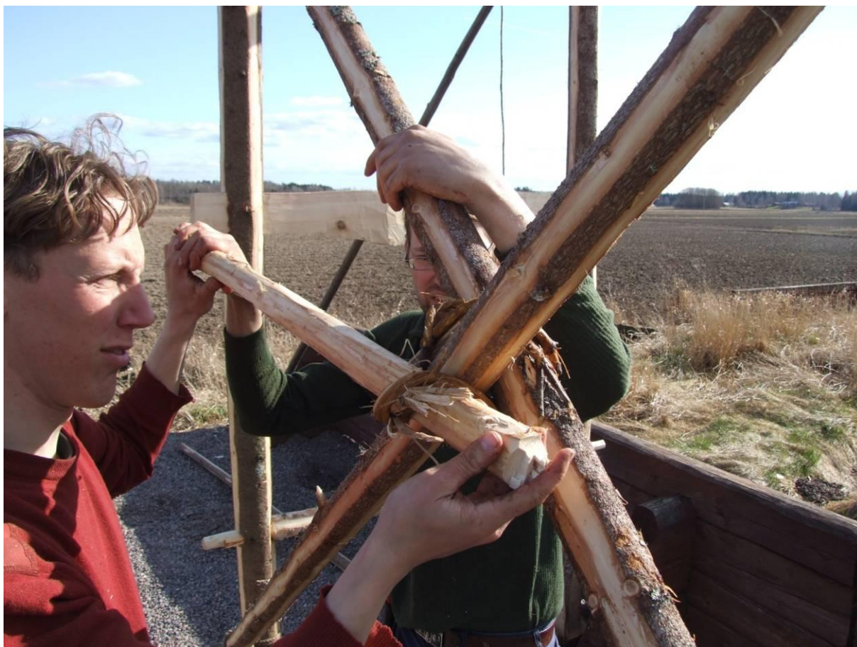
9. Uppspänning av vidja med hjälp av pinne (hävvarm). När förbandet är spänt låses pinnen med en lina till närliggande sträva. Förbandet går enkelt att efterspanna. Strävorna som korsar varandra går mellan spirpar 1 och 2.
