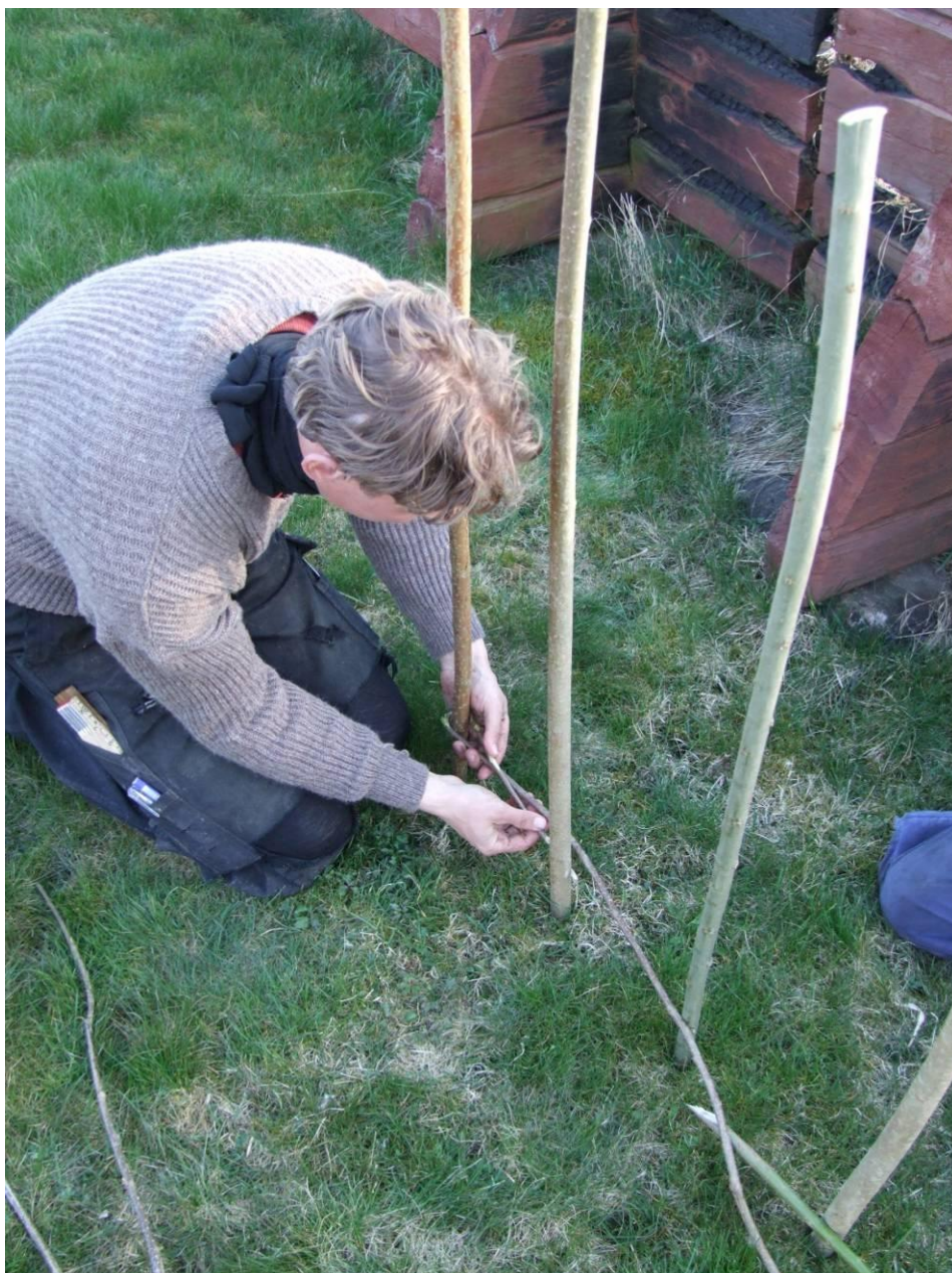
12. Första vidjan på plats i flätverket
