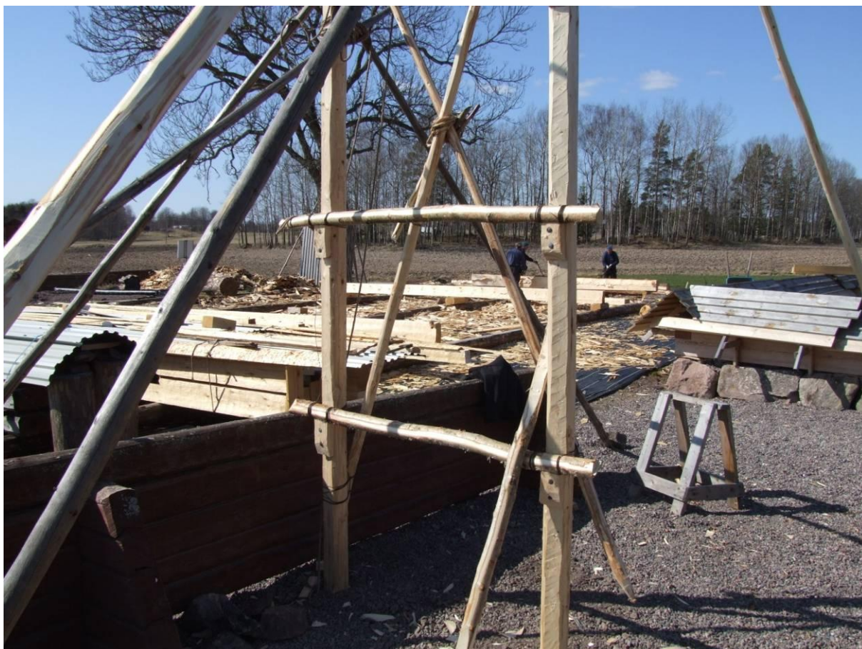
4. Spirpar nr 1 på plats. Mellan spirorna syns den undre delen av två korsade strävor. Där strävorna korsar varandra är dom förbundna med en vidja som är slagen två varv runt strävorna. Genom att trä in en pinne genom vidjan och sedan dra runt så ökar man draget i vidjan och man får ett mycket stadigt förband. Bommarna vilar på spikade klossar med surring av tjärad hampa.
