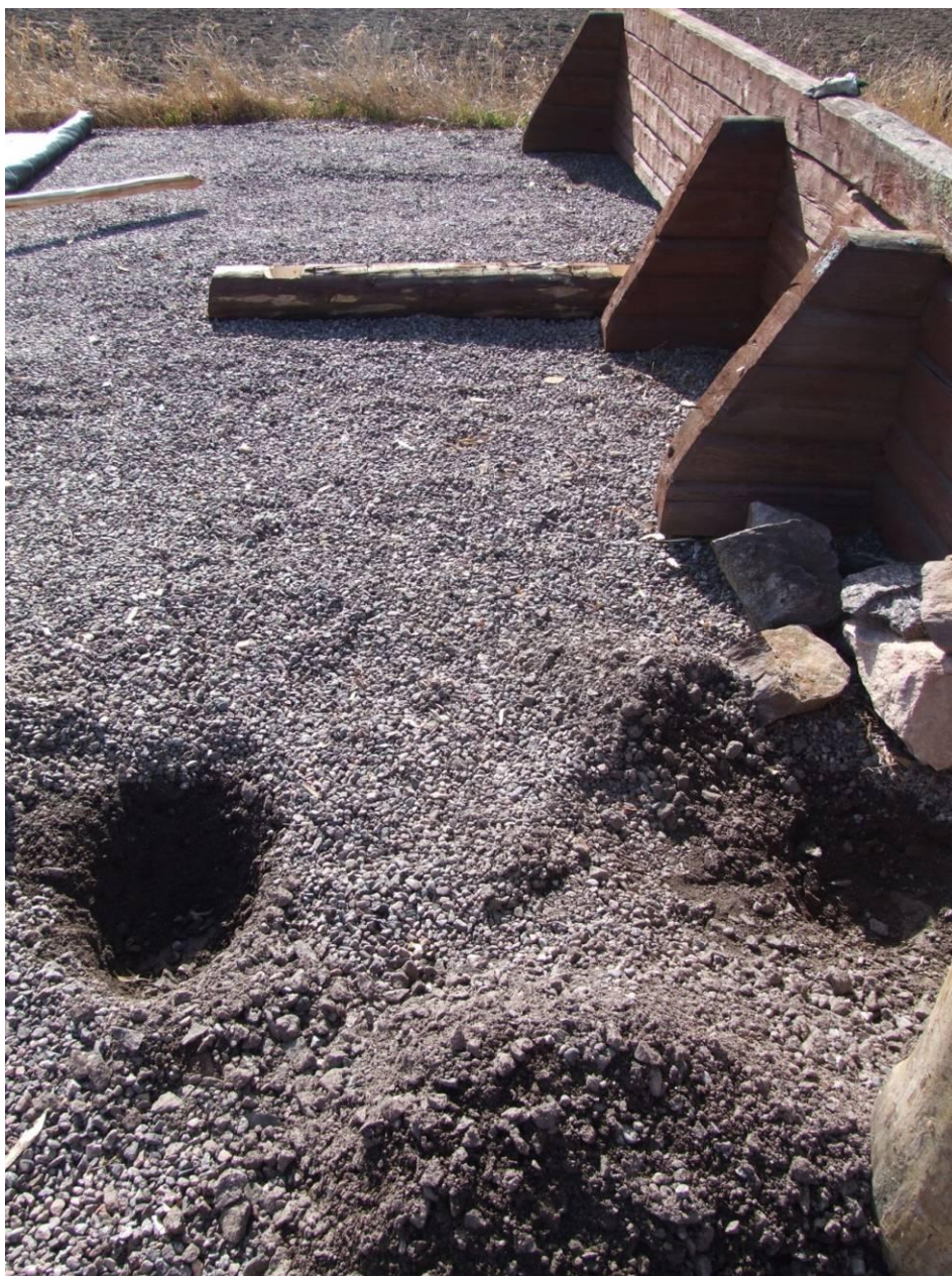
2. Närmast gropar för spirpar nr 1. Längre bort halvklov med uttag för spirpar nr 2. Halvkloven fungerar som stöd och fixering för spirorna. Ett alternativ till att gräva gropar.
