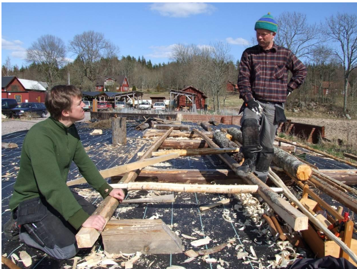
5. Spirpar nr 2 med genomgående bommar av olika slag. Spirorna är fyrkantigt huggna för att passa bra i halvkloven som man ser i bild 2.
